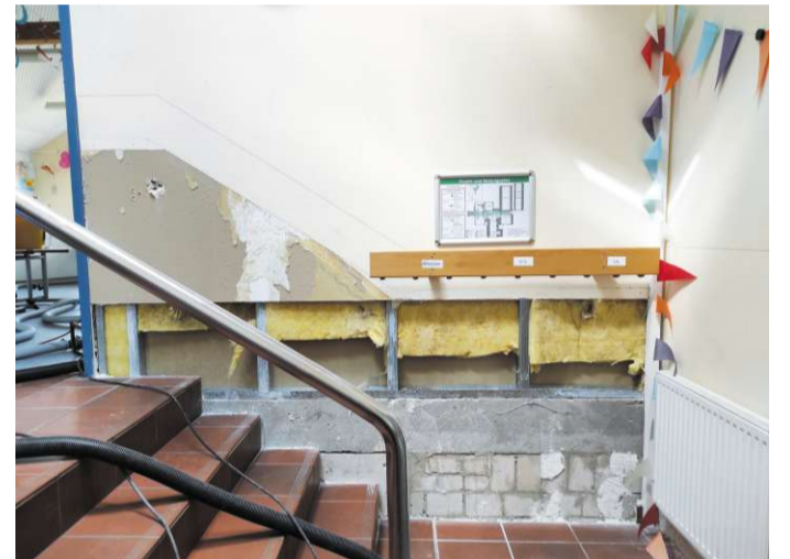
Ein konträres Bild: Links ist die Brandschutzwand geöffnet, rechts baumelt noch eine letzte Wimpelkette.
