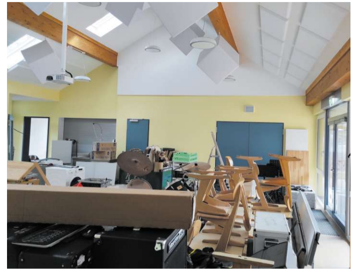
Die Mensa, gerade erst fertiggestellt, blieb weitestgehend verschont: Jetzt dient der Raum zwischenzeitlich als Materiallager.
